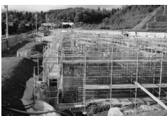
新体育館建設状況
