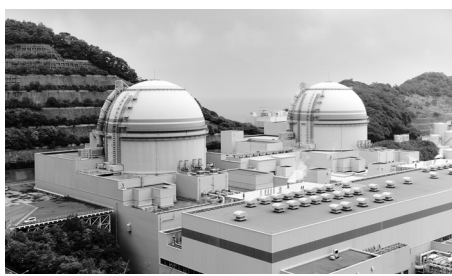
大飯原発 (資料提供: 関西電力株式会社)
