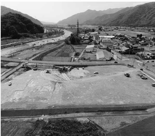
工事が進む「道の駅恐竜渓谷かつやま」
