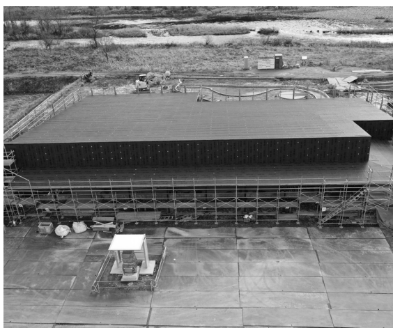
建設が進む道の駅
