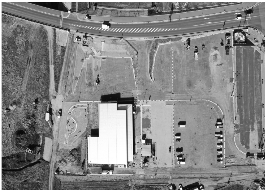
建設が進む道の駅
