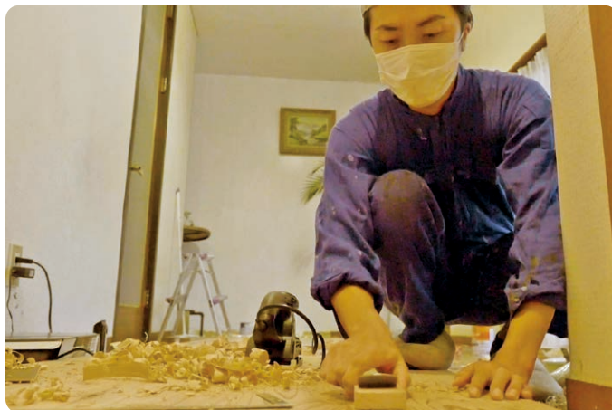
*写真は作業の様子
