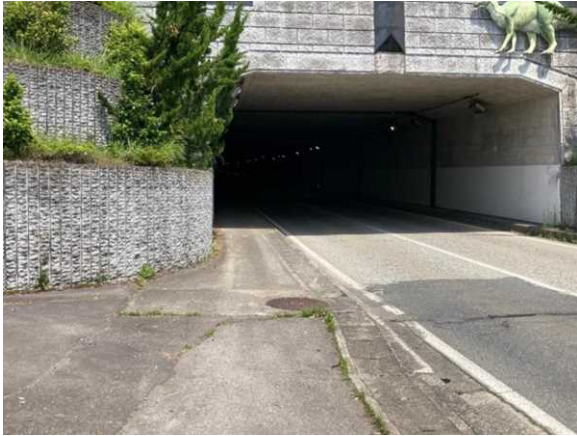
⑦トンネル入口（勝高側）
