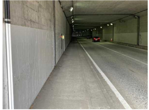
⑧トンネル内の歩道
