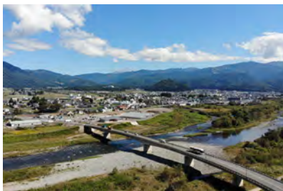
県道勝山インター線（勝山恐竜橋）
