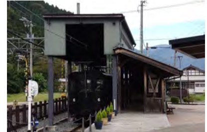
電気機関車テキ6 展示施設
