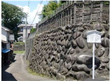
旧勝山城下域の七里壁(市)
