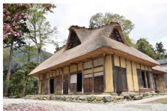
旧木下家住宅 (建造物・国指定)
