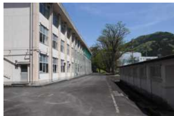
⑥ 特別教棟（昇降口棟より）
