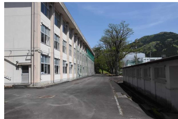
⑥ 特別教棟（昇降口棟より）
