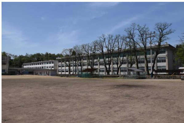
③ 特別教棟（グラウンド側より）
