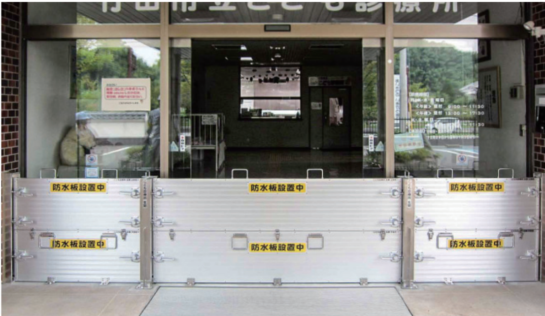
脱着式防水板設置イメージ
