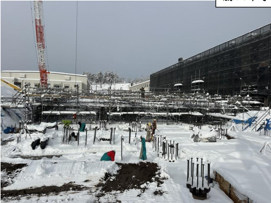
①基礎工事
