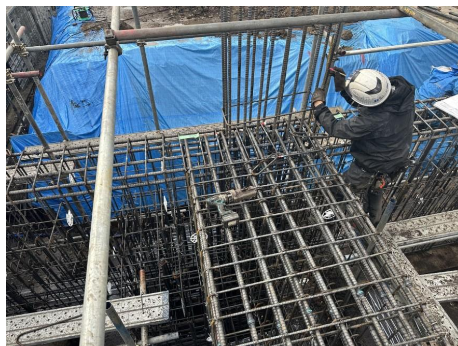
④基礎工事
