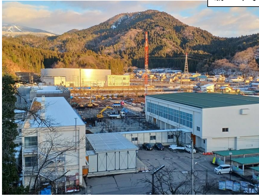
①基礎工事 長山公園側から
