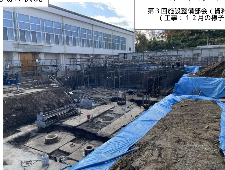
②基礎工事
