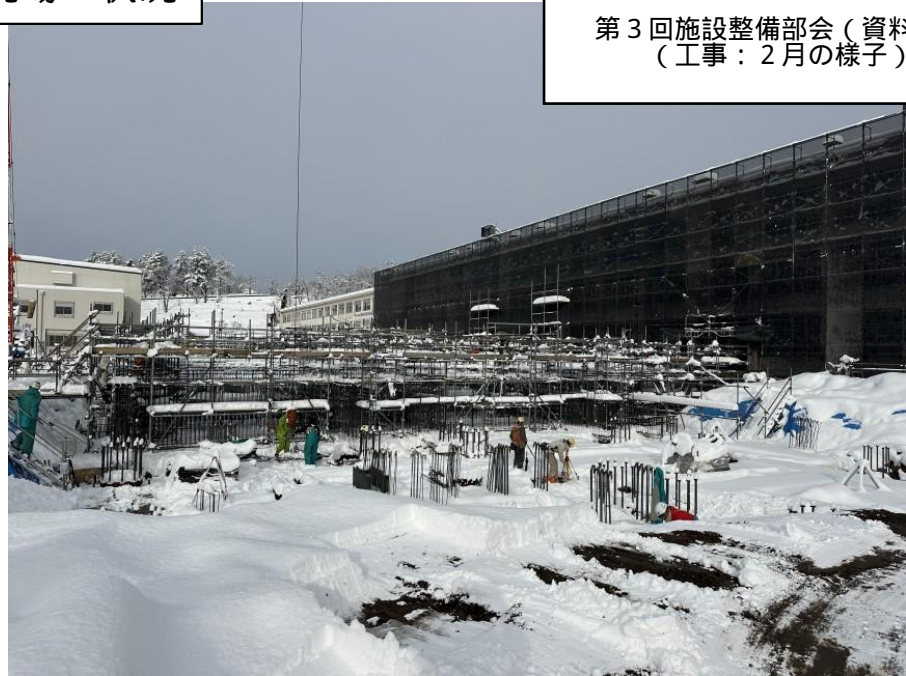
②基礎工事
