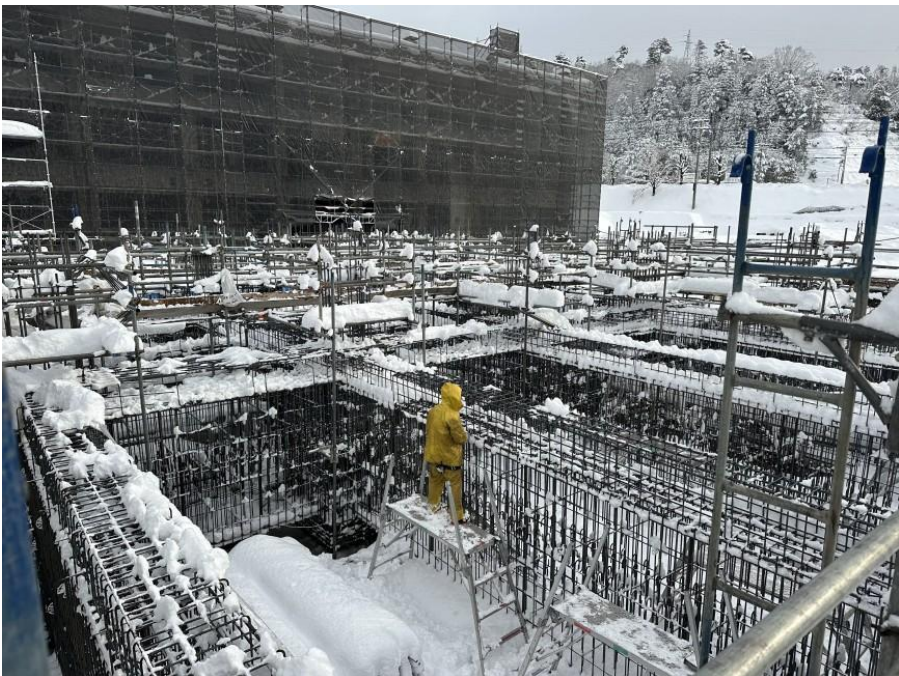
③基礎工事(配筋工事)
