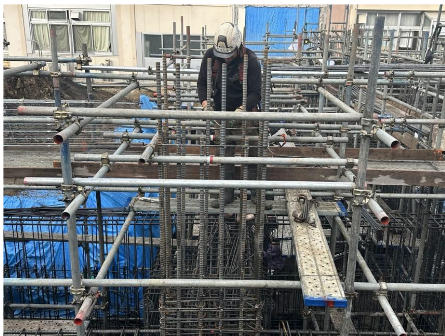
③基礎工事
