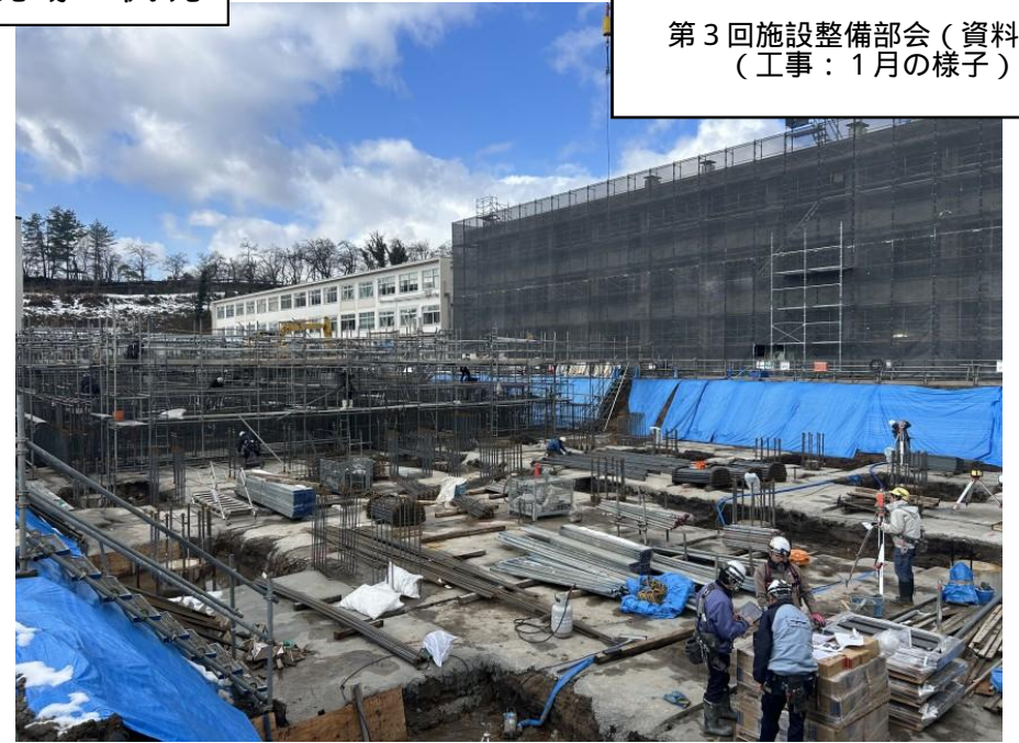
②基礎工事
