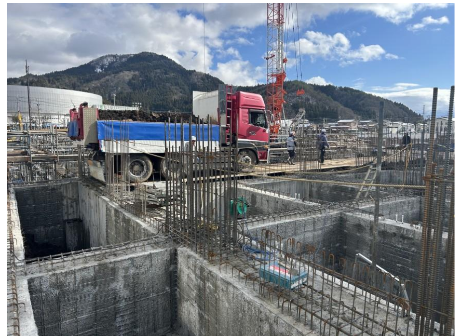
④基礎工事(コンクリート工事)
