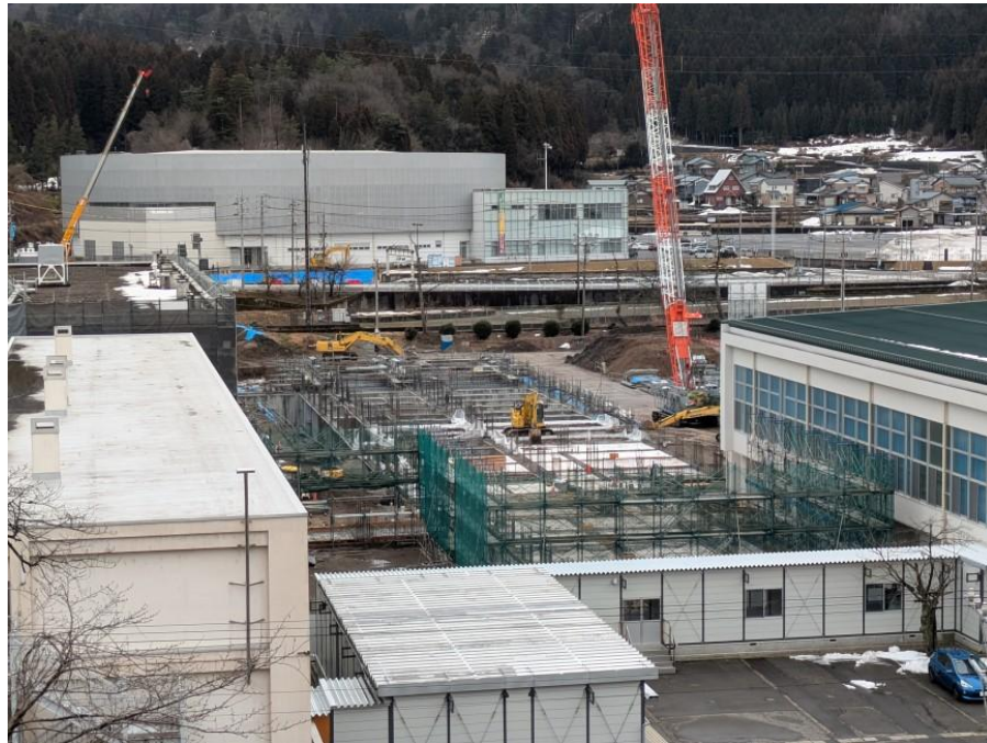
①基礎工事・1階躯体工事 長山公園側から
