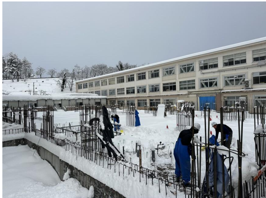
④基礎工事(配筋工事)
