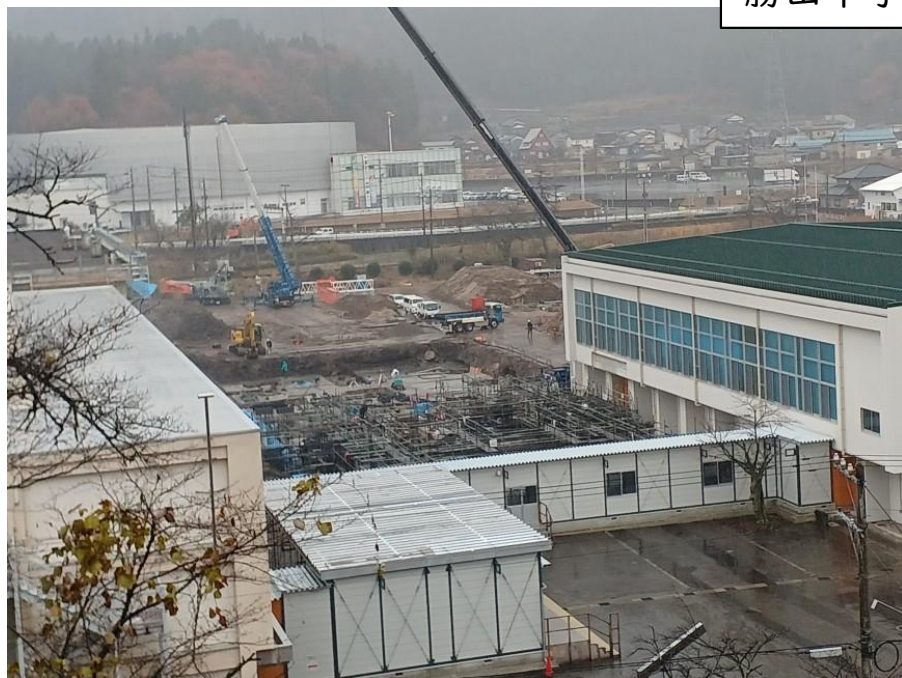
①基礎工事 長山公園側から
