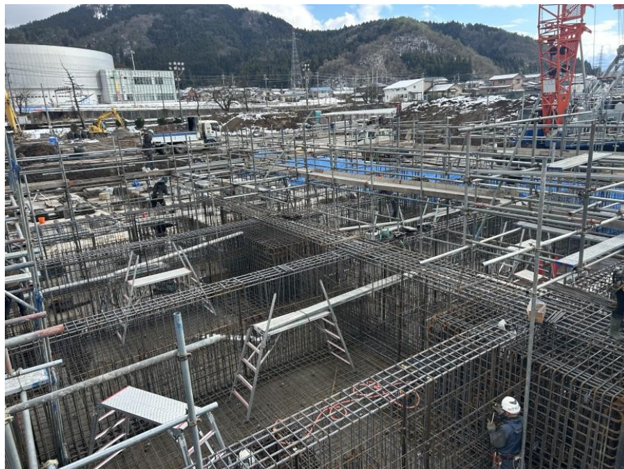
③基礎工事(配筋工事)
