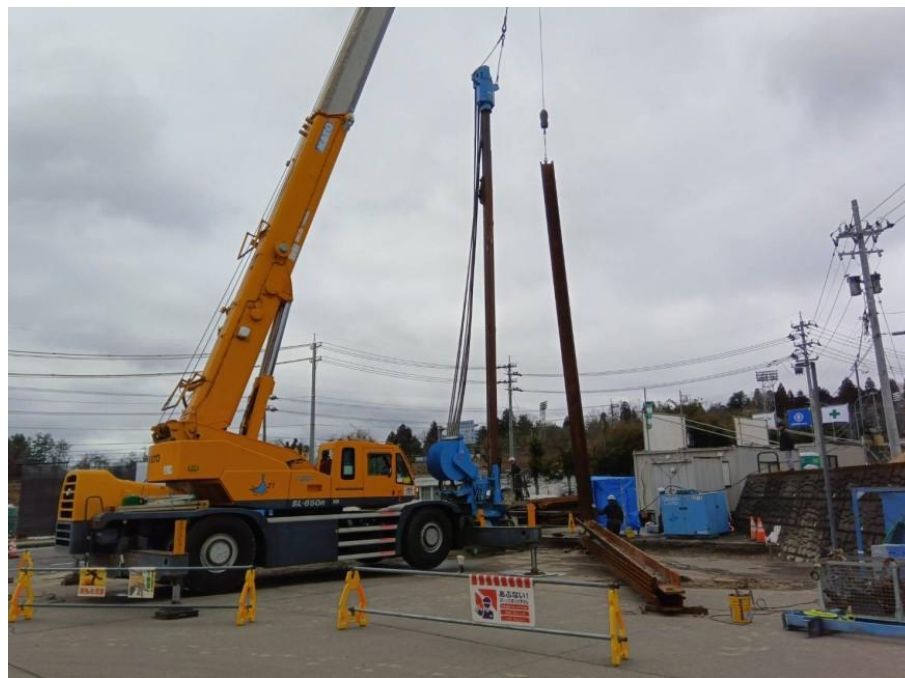
④仮設工(矢板圧入)
