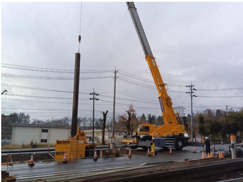
③仮設工(矢板引抜)
