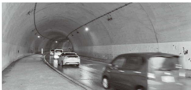
長山トンネル内
