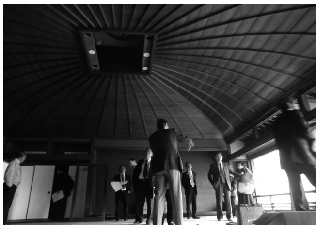
現地視察：2階座敷の傘天井の様子
