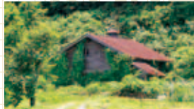
旧神谷発電所
