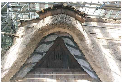
現地工事風景
