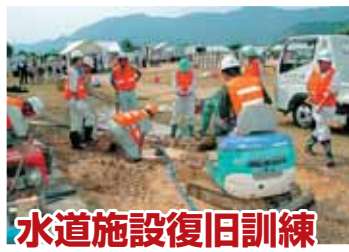
勝山市水道事業協同組合および市職員による、破損した給水管の応急・復旧作業を実施
