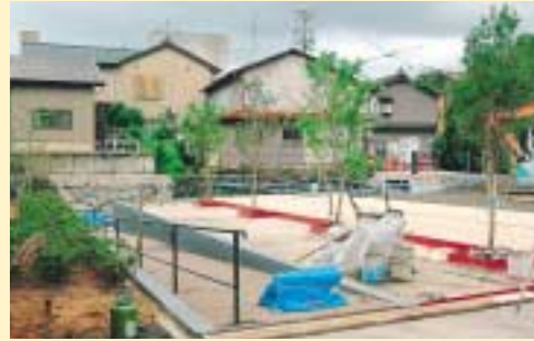
完成間近の大清水広場
