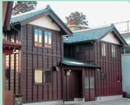
外壁を板張りにした建物
