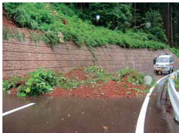
平泉寺町小矢谷地係 広域農道で法面崩壊により道路をふさぐ（19日撮影）
