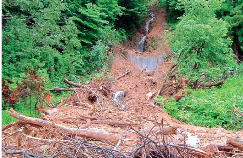
北谷町小原地係 山腹で土砂崩れ発生（19日撮影）
