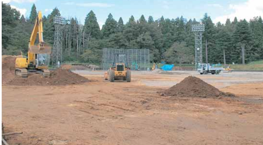
排水溝整備などの工事が進む長山公園グラウンド
