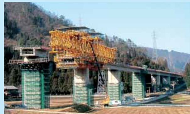
橋梁上部工事が進む「吉峰高架橋」
