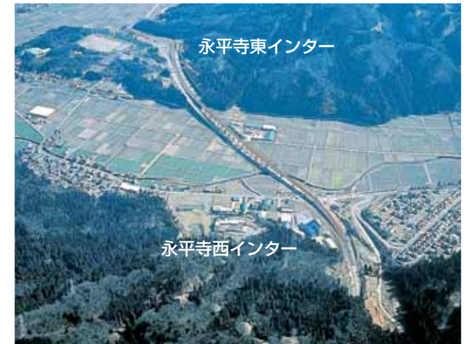
開通した永平寺西インターから東インター間
