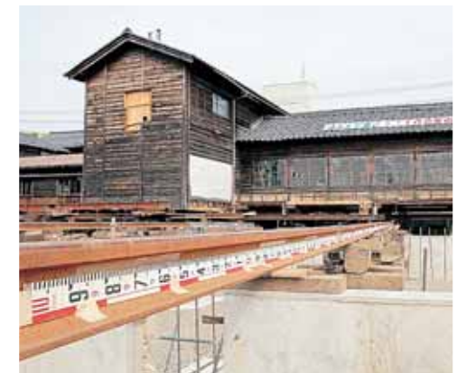
レールにはメジャーが付けられ、距離を正確に測定しました
