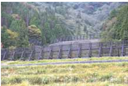
雪崩防止堰堤
