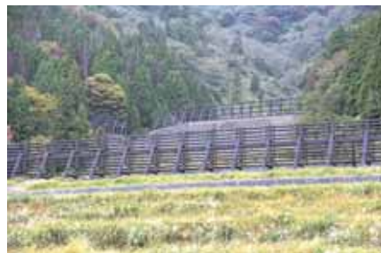
雪崩防止堰堤
