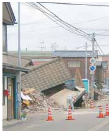
平成19年新潟中越沖地震の被災状況
