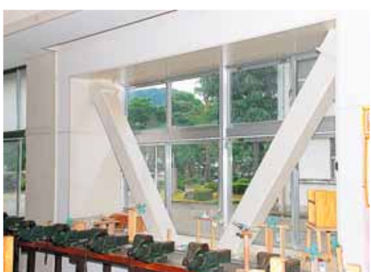
耐震補強を終えた勝山中部中学校の教室
