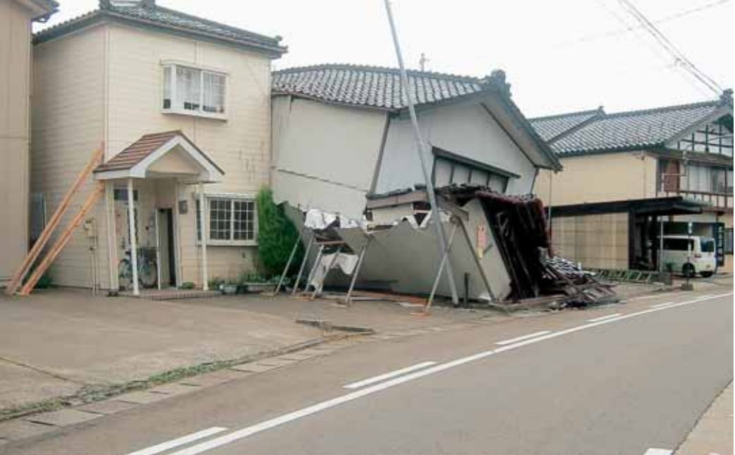
新潟県中越沖地震での柏崎市の被害の様子 (写真提供：福井県)
