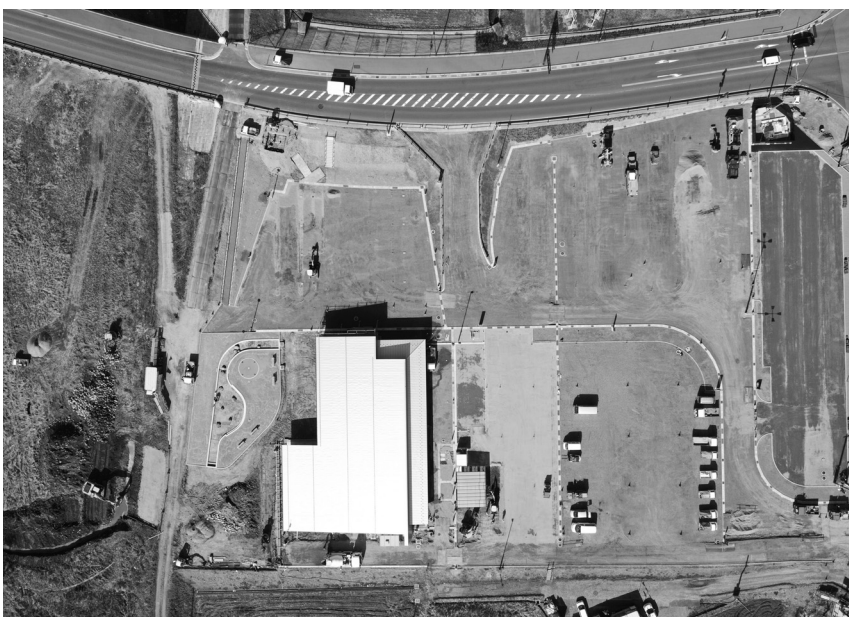
建設が進む道の駅
