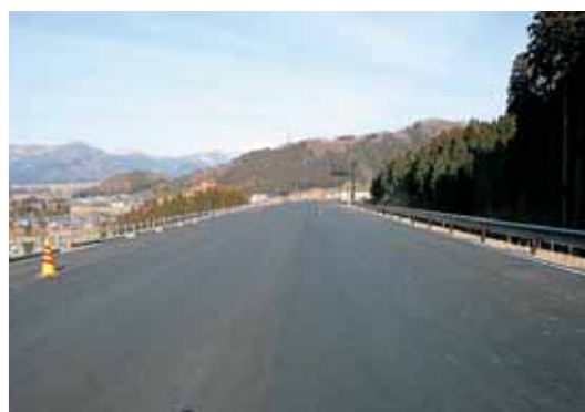
整備が進む中部縦貫自動車道勝山インター付近
