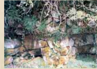
近くの野津又地籍の小字「堀切り」に設けた倉田源右衛門窯、火を焚く口が二つ並んでいる。この上に円筒形石積みみの窯があった。この窯の石灰石は近くの野津又地籍の山から採掘していた。
