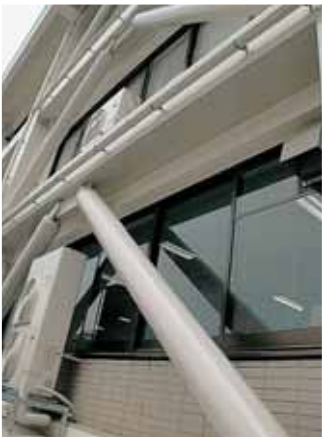
見た目にも美しい丸パイプ方式の筋交い
