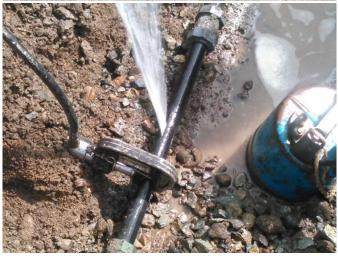
給水管(ポリエチレンパイプ) からの漏水状況
