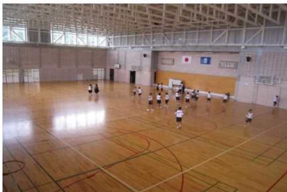
体育館 長手方向中央にステージ（可動式）がある珍しい体育館
