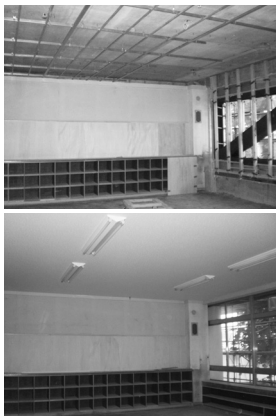
非構造部材の耐震工事(南小学校)
