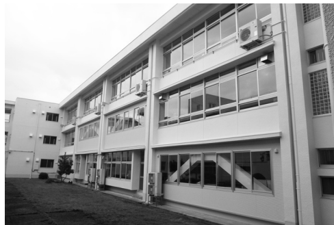
耐震補強・大規模改造工事後の成器南小（北校舎）
