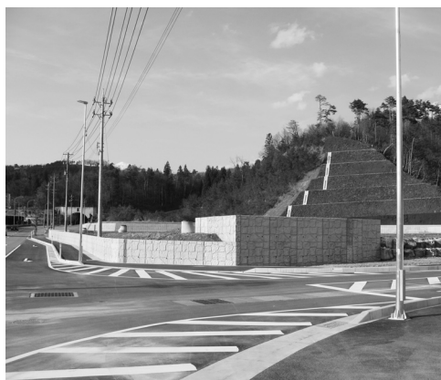
造成中の新体育館建設地
