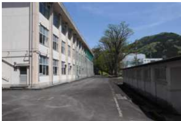
⑥ 特別教棟（昇降口棟より）
