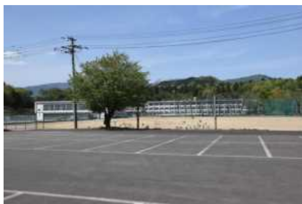
② グラウンド (敷地南側より)
