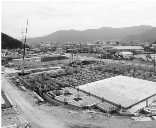
新体育館建設現場
