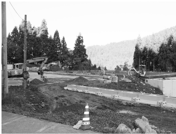
北谷町コミュニティセンター建設現場
