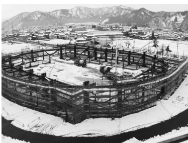
新体育館建設状況
