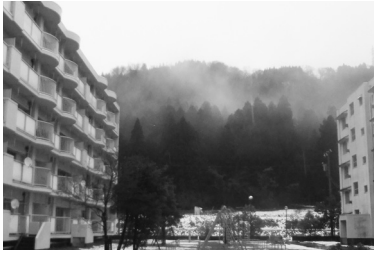
雇用促進住宅鹿谷宿舎
