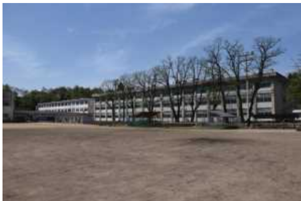
③ 特別教棟（グラウンド側より）
