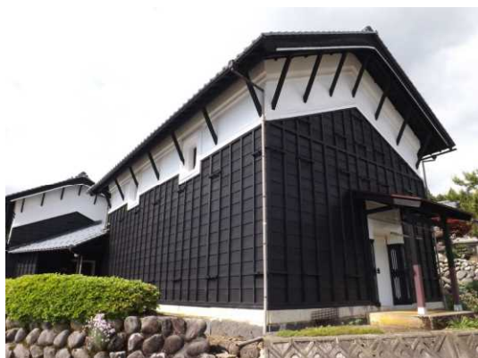
写真 3-39.「方杖」※をもつ土蔵 ※屋根を支えている部材
