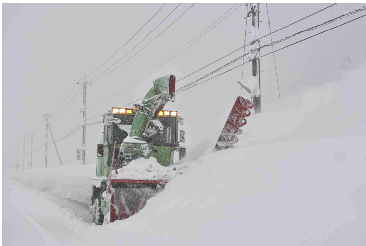
除雪作業状況（勝山市内）
