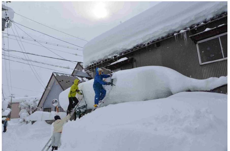
市職員による危険家屋の雪下ろし
