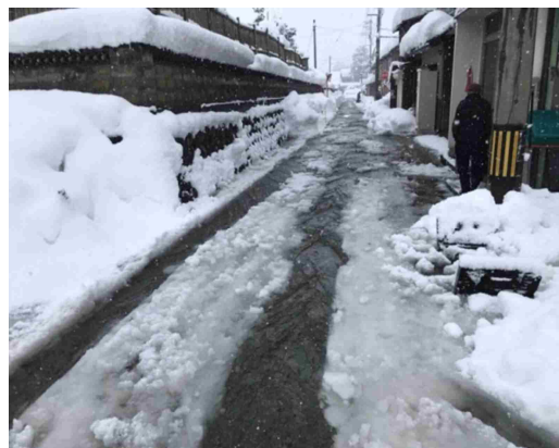
雪詰まりによる道路冠水
