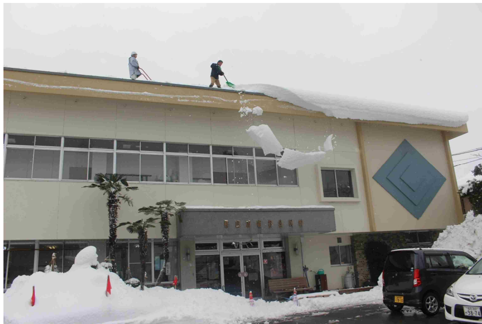
鹿谷公民館の屋根雪下ろし
