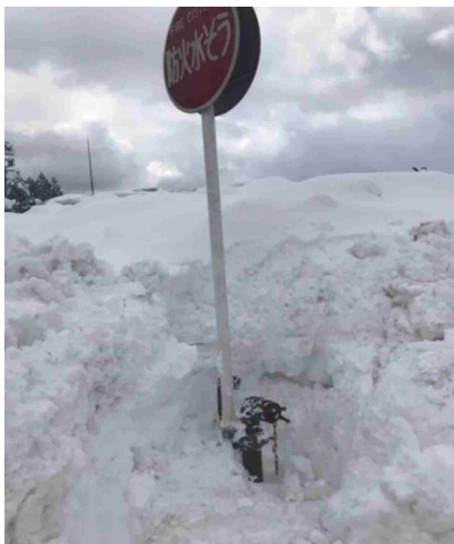
防火水槽吸水管の除雪
