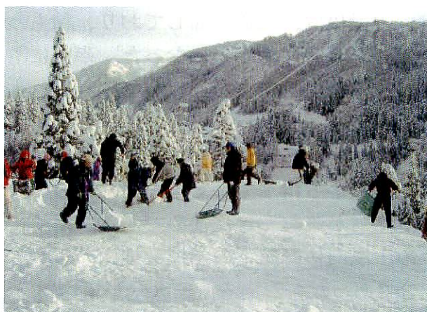
かつやま子どもの村小中学校屋根雪下ろしの様子(2) ※見かけは平地の除雪だが、体育館の屋根の上である。 積雪量が多いため2～3層に分けて雪下ろしを行った。
