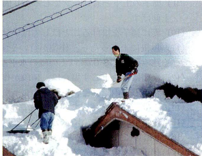
市内の屋根雪下ろし作業の様子
