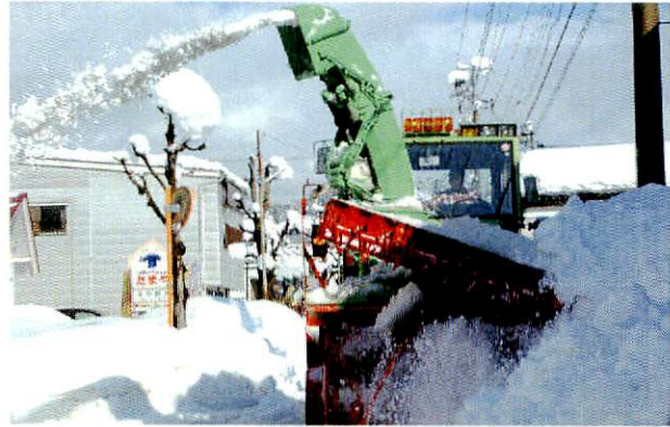
ロータリー車による拡幅除雪
