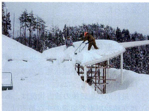
公園内のテントの雪下ろし
