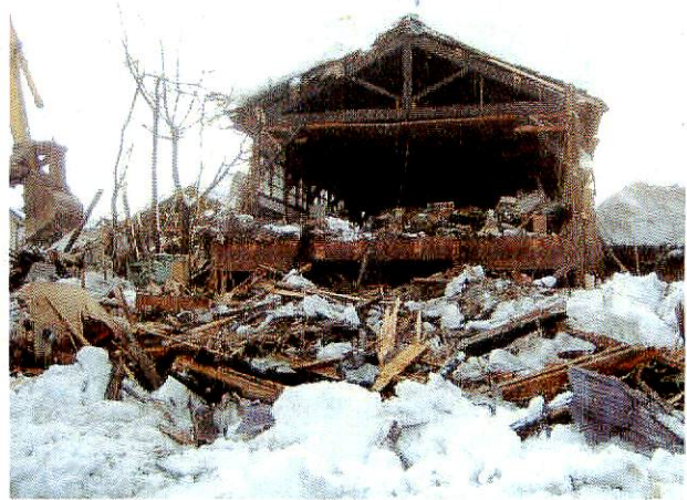
一部倒壊工場の解体
