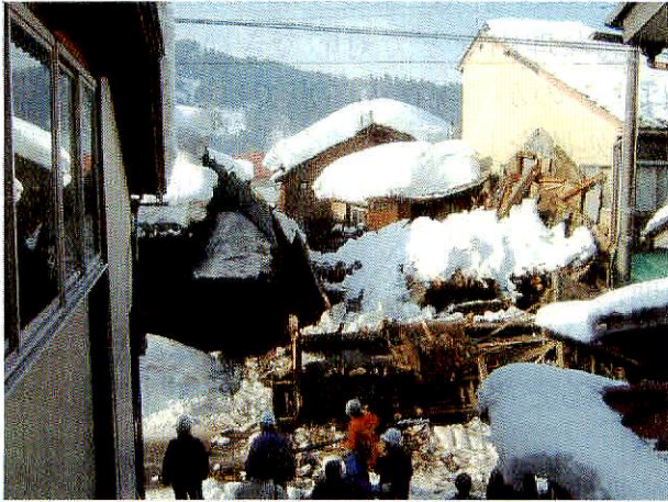
工場の倒壊直後の対応状況
