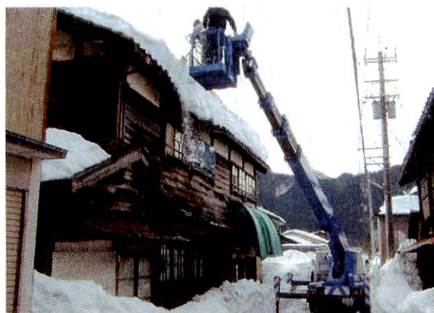
スカイマスター車を用いた作業
