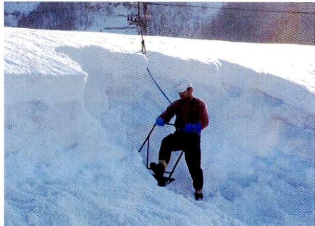
安全帯、ロープを用いた作業
