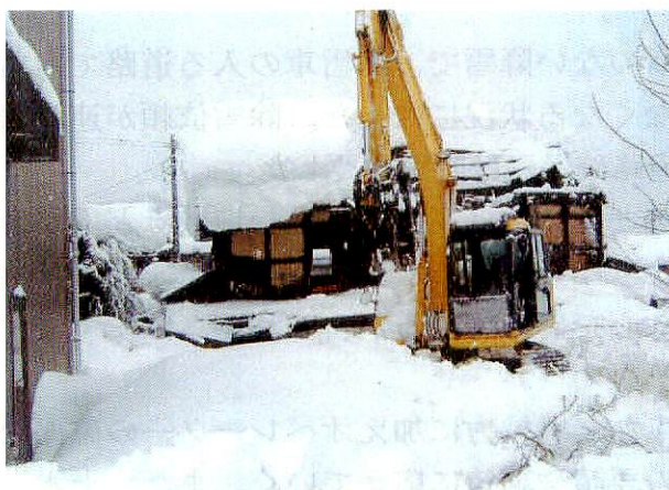
倒壊危険家屋の解体
