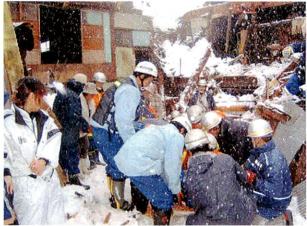
倒壊による被害者の救出
