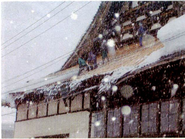
軒が折れ瓦も落下した寺院
