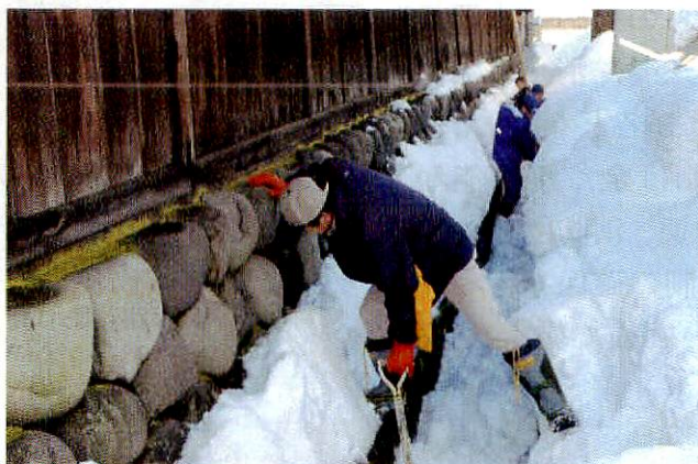
流雪処理能力を超えた水路
