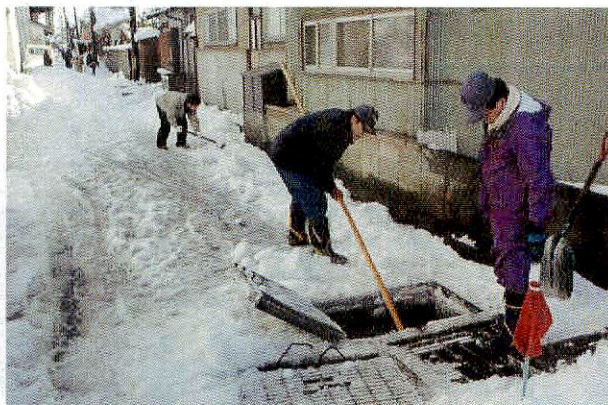
水路詰まり対応の様子
