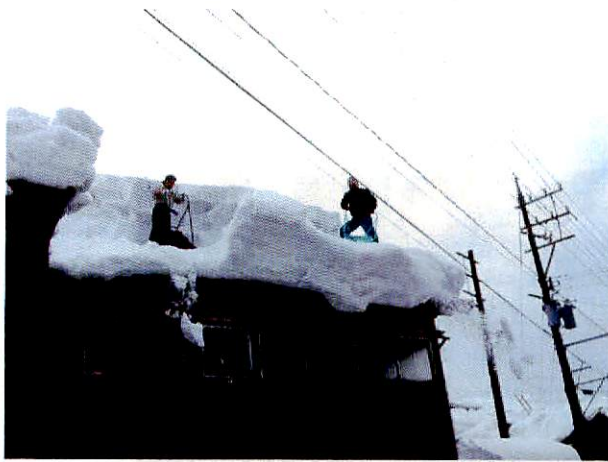
職員による危険家屋の雪下ろし（１）
