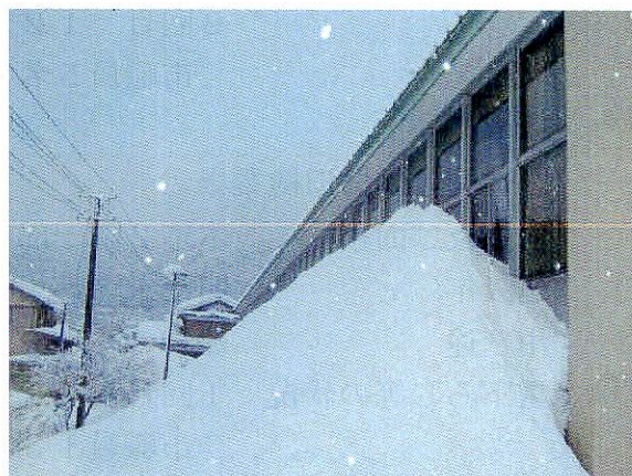
市営体育館の堆雪状況
