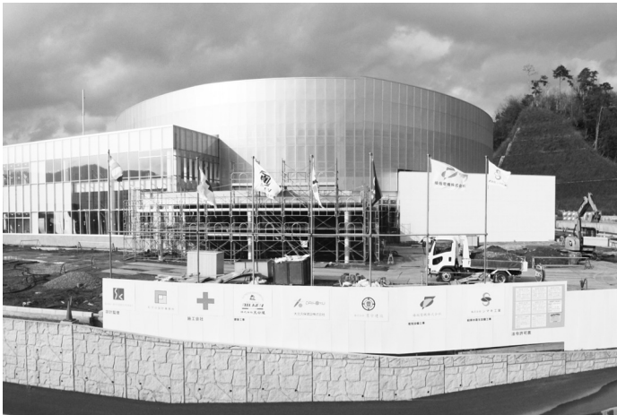
新体育館建設状況（外観） H27.12.25
