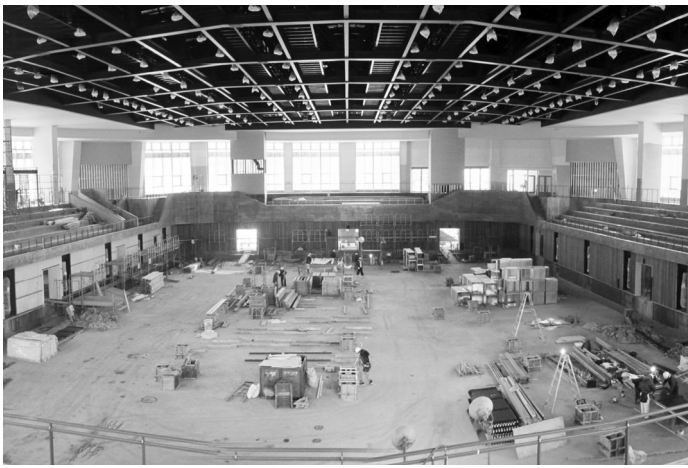
新体育館建設状況（内部） H27.12.24
