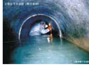
正常な下水道管(他市事例)
