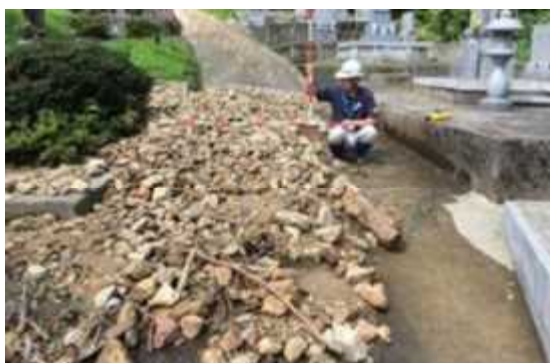
② 平成 29 年 8 月 25 日 大雨被害 民家付近まで土砂流出
