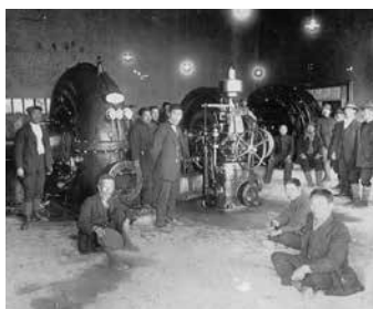
薬師発電所内部
